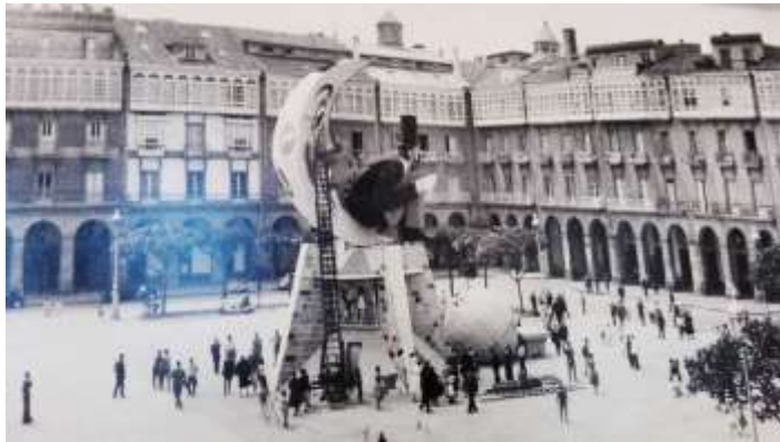
La falla de 1959
