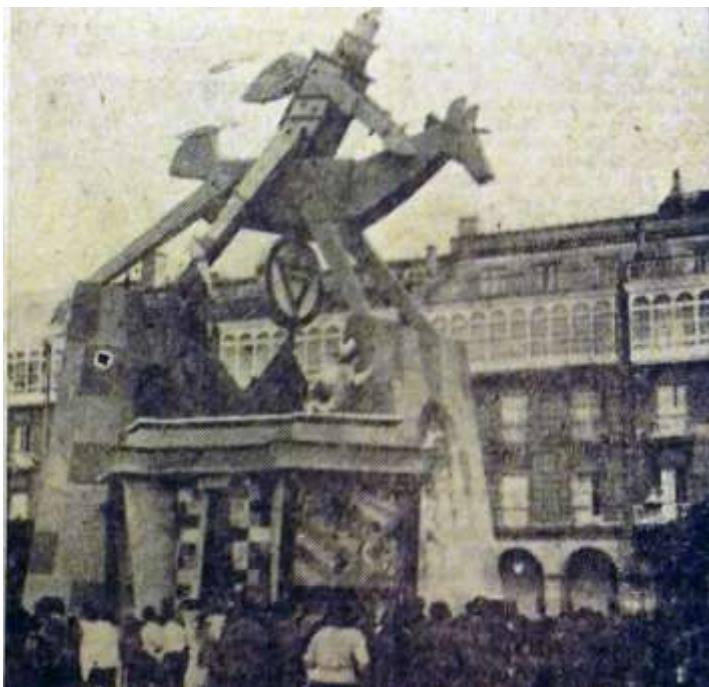
La falla de 1963
