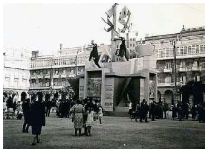
La falla de 1964
